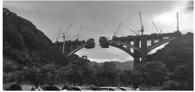
写真—2 近づく中央径間の移動作業車
