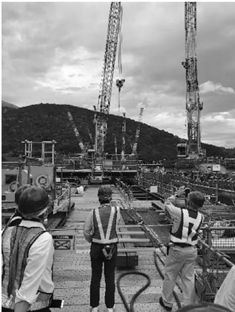
写真—9 運搬台車とトラバークレーン
