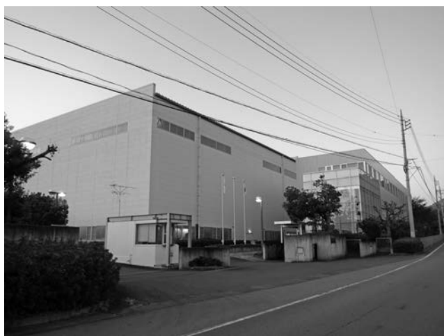
写真—1 塩山工場外観
