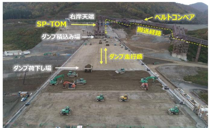
写真—1 堤体全景と材料運搬システム
