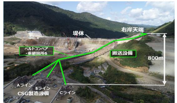
写真—2 搬送設備(プラント～右岸天端)
