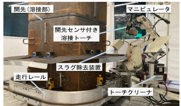
マニピュレータ型現場溶接ロボット
