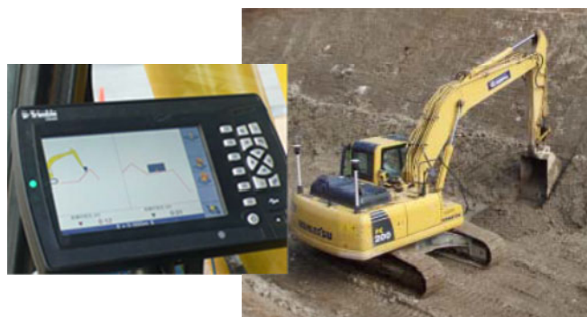
ICT 建設機械による施工と車載モニタ例
