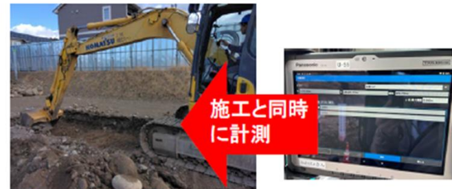
②3D-MG施工 + ②刃先による計測
