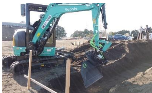
刃先が届かない細部を人力作業
