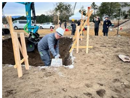
手元作業員が多い現場
