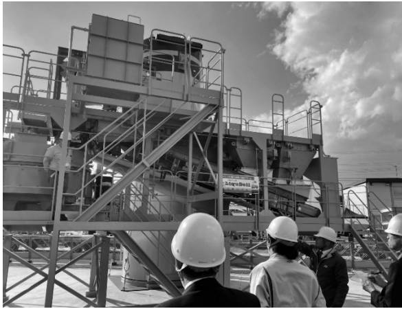
写真一五 ユニット型流動化処理土製造プラント製品
