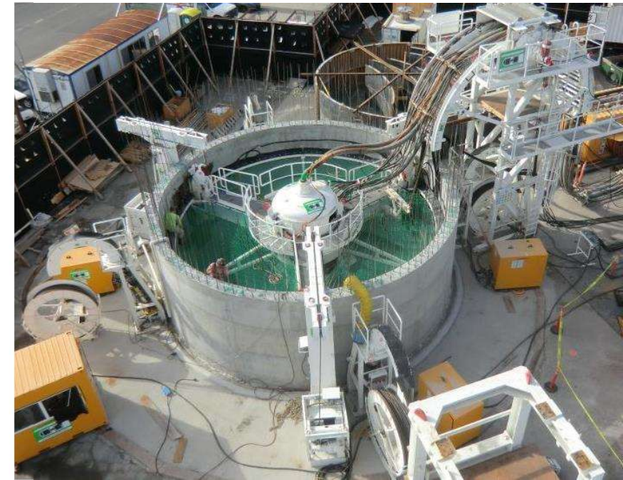
VSM working under groundwater 地下水下で稼働するVSM
