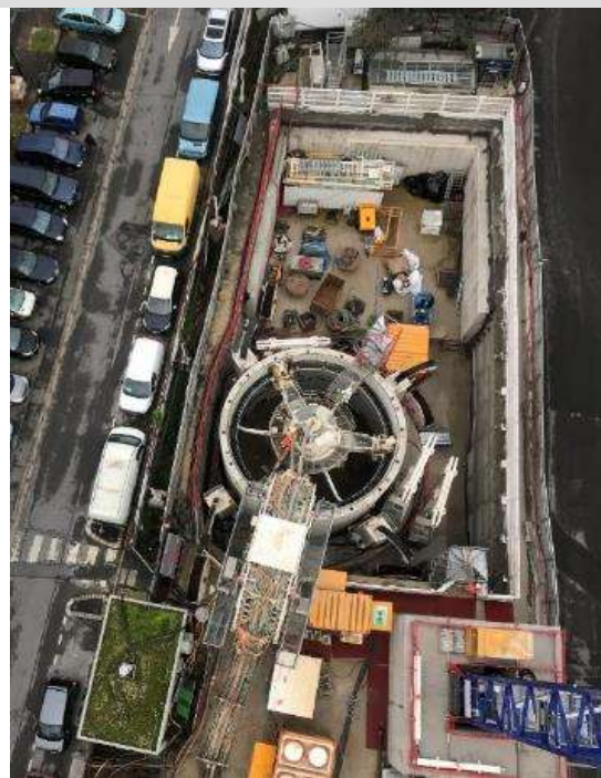
GPE – Paris, France パリ・フランス Shaft OD up to \Phi 12,800 mm 立坑外径 \Phi 12,800 mm
