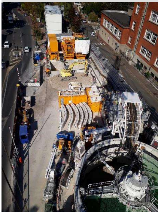
GPE – Paris, France パリ・フランス Shaft OD up to \Phi 12,800 mm 立坑外径 \Phi 12,800 mm
