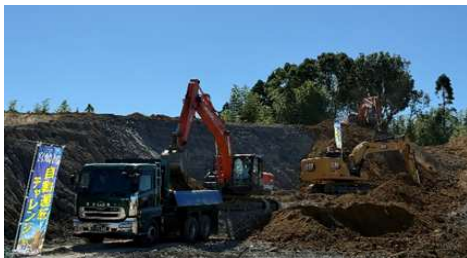
自動施工中の様子
