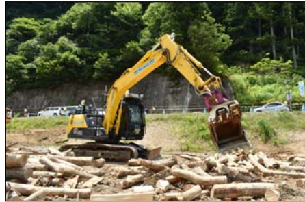
写真-1 フェラーバンチャーを装着したバックホウ
