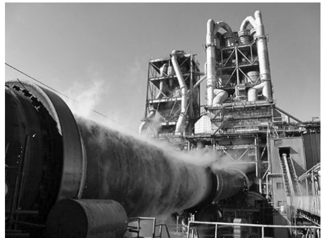
写真一六 サスペンションプレヒーターとロータリーキルン（地上から）
