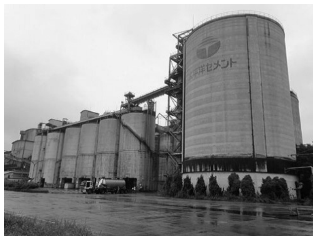
写真-2 セメントサイロ群
