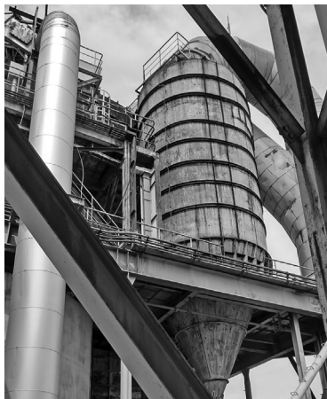
写真一五 写真一四の左上方に見えているサスペンションプレヒーターの最上部
