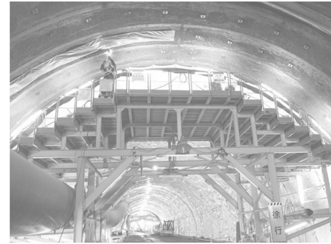
【防水シート張り】
