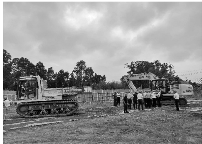
写真-3 重機ヤード状況
