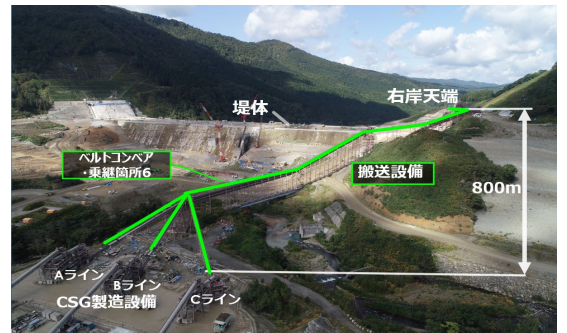
写真—2 搬送設備(プラント～右岸天端)
