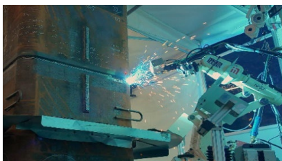
自動溶接中の状況
