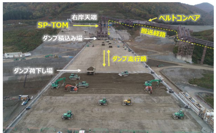
写真—1 堤体全景と材料運搬システム
