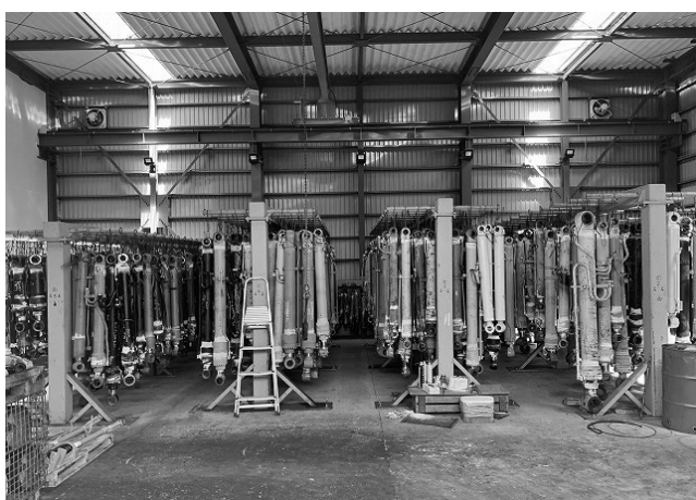
写真-4 油圧シリンダ倉庫
