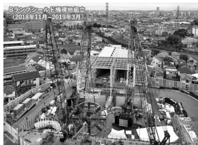
写真-1 シールドマシン組立状況
