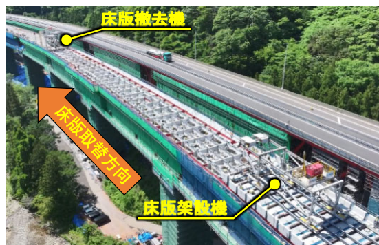
写真-1 SDRシステム施工状況
