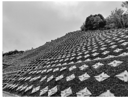
写真—6 左岸側のり面状況
