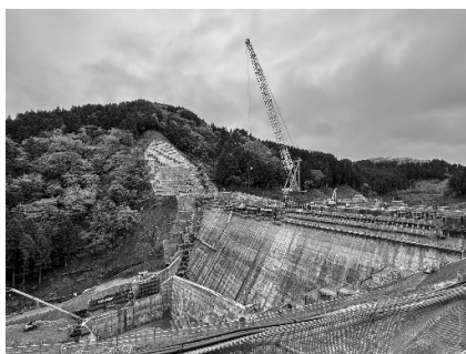
写真—2 堤体（本体）工全景
