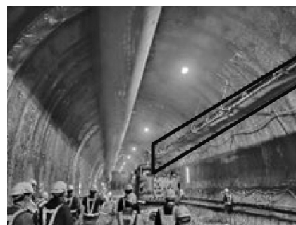
写真一三 ベルトコンベア配置
