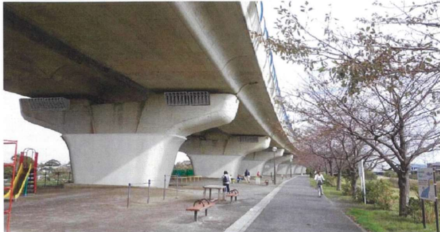
支承補強(水平分担構造)
