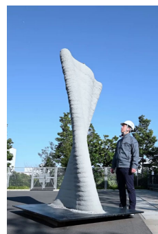
図5 曲面部材施工
