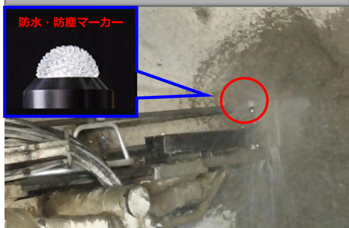
削孔時のマーカ状況
