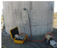
道路橋脚での透気試験
