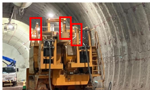
シャッターターゲットにより重機位置を高精度算出
