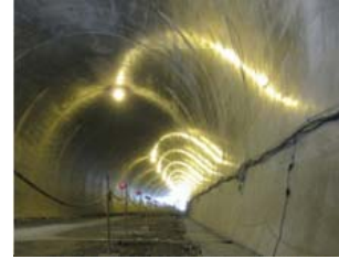
覆工コンクリート仕上がり状況
