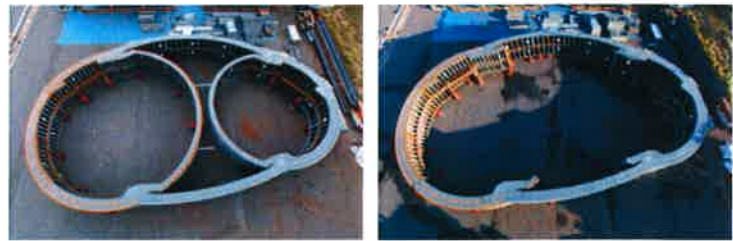
写真-1 アーチセグメント仮組
