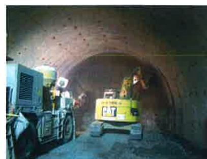
写真-4 吹付けと他作業の同時施工状況
