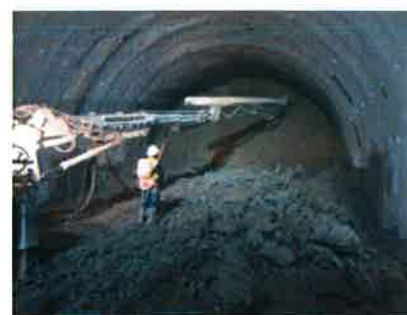
写真-3 ずり出し前の吹付け状況
