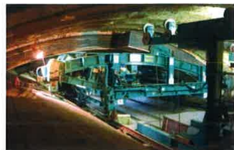
写真-2 アーチセグメント組立装置
