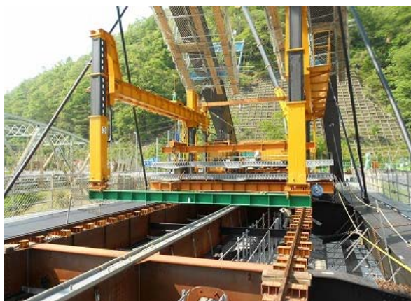
PC床版架設機
