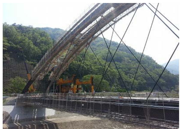
床版架設状況
