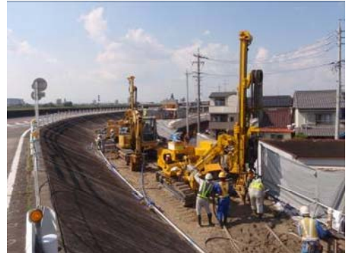
既設河川堤防上における施工状況
