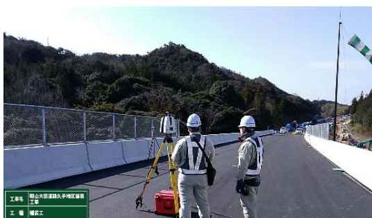
基層上面 TLS 測量「面計測」(計測間隔 40m)
