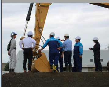
ICT建機施工体験
