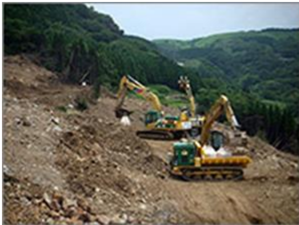
図 1 阿蘇大橋地区における無人化施工
