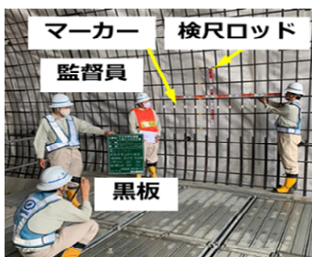
従来の配筋検査
