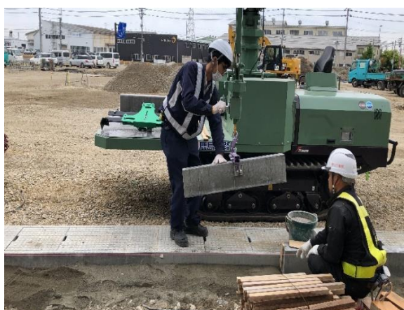
写真-7 片面歩車道ブロックA設置状況
