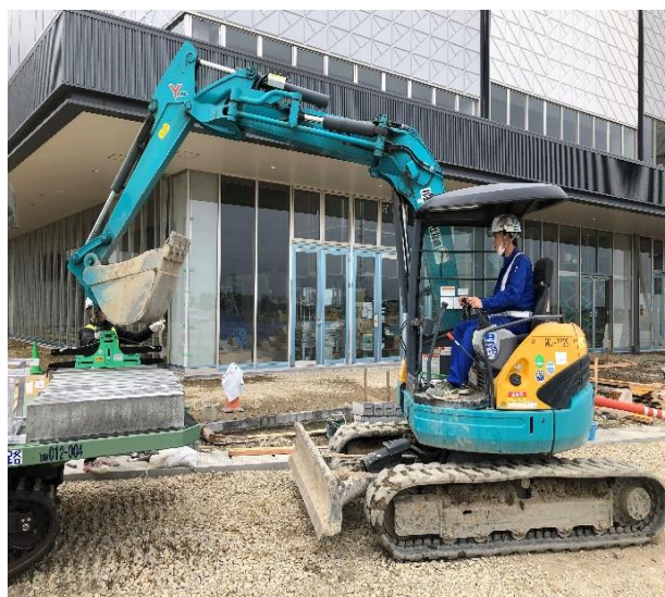
写真-2 油圧ショベルを用いた設置作業
