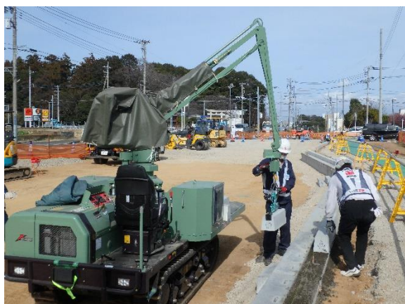
写真-6 両面歩車道Aブロック設置状況
