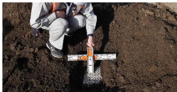
写真-6 ICT施工実施時の掘削結果
