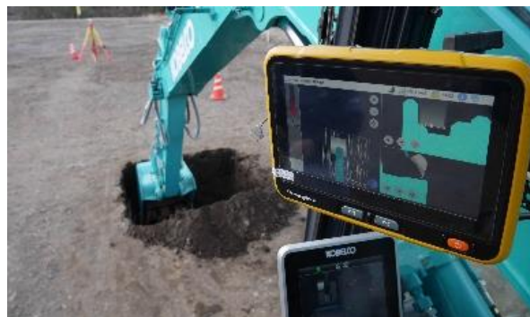
写真-4 ICT建機による掘削作業
