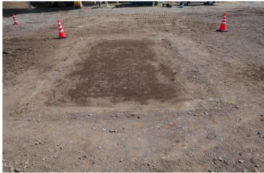
写真-2 埋設管設置完了状況
