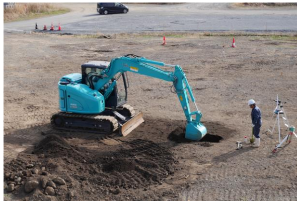
写真-5 従来建機による掘削作業
