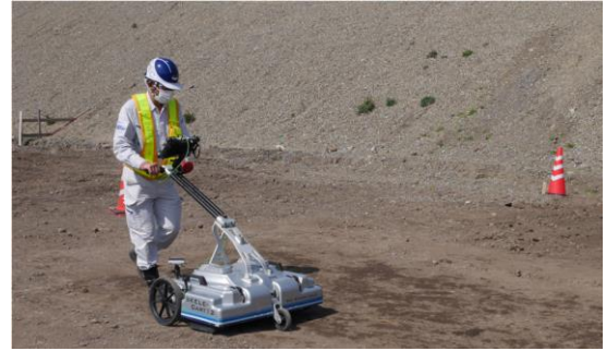
写真-3 地中探査の実施状況
