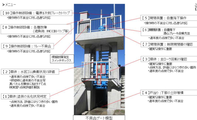
図-6 ラック式開閉装置
