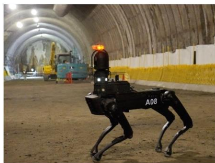
写真-2 自律歩行によるトンネル坑内の巡視
