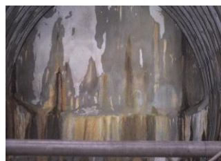
写真-3 切羽写真 (30m 離隔)
