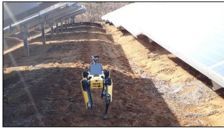
写真-12 ソーラーパネル裏の自動点検状況
