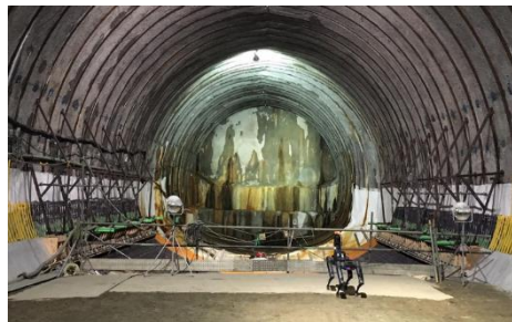
写真-1 現場適用性の検証
