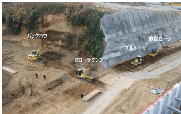
写真-4 自動建機の協調運転システム
