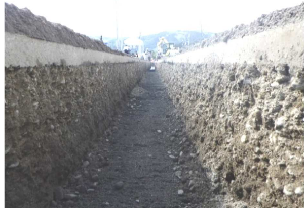
写真-3 掘削後の仕上がり状況
