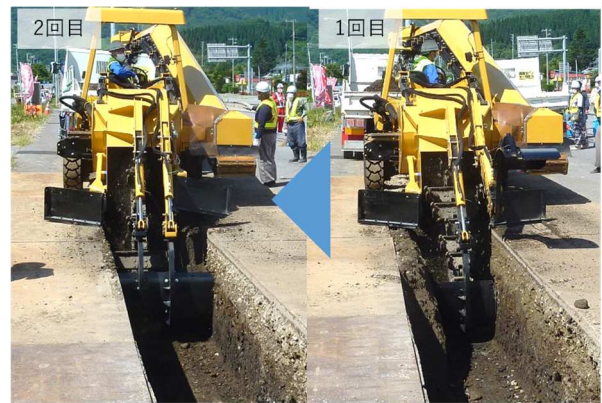
写真-5 トレンチャーでの掘削状況
