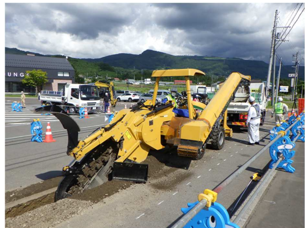
写真-2 トレンチャーによる施工状況
