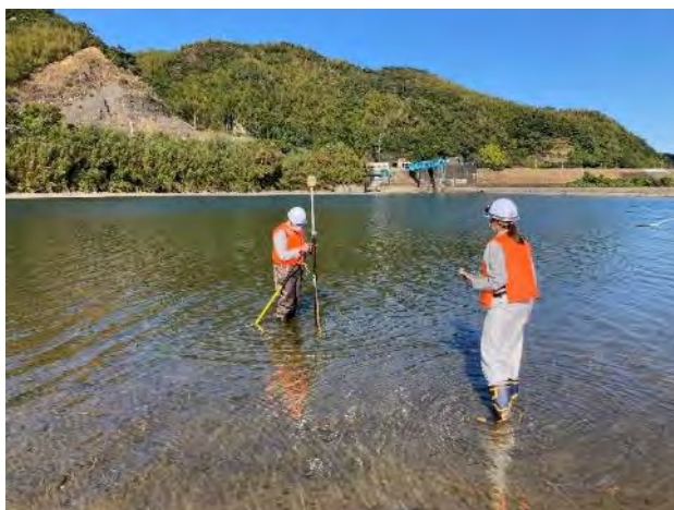
図-9 VRS-GNSS 計測状況
