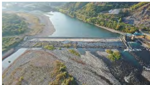
図-2 実証した現場の UAV 写真
