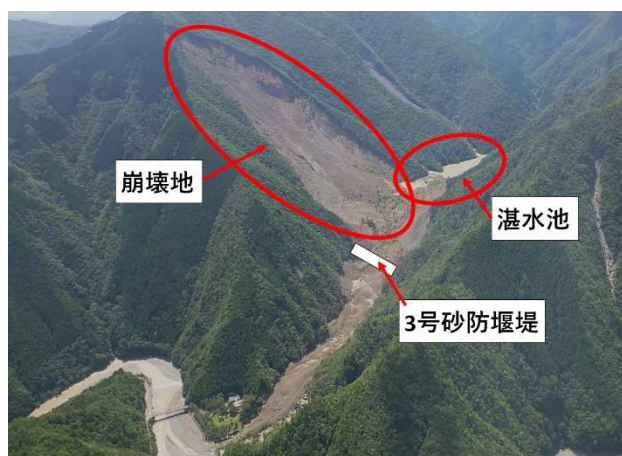
写真-1 災害発生直後の状況と堰堤施工場所
