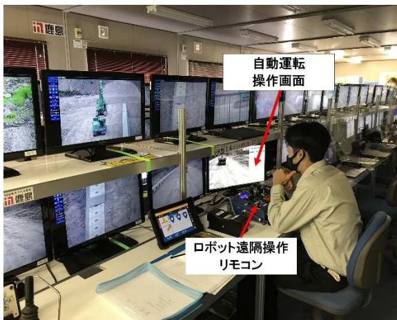
写真-5 操作室状況
