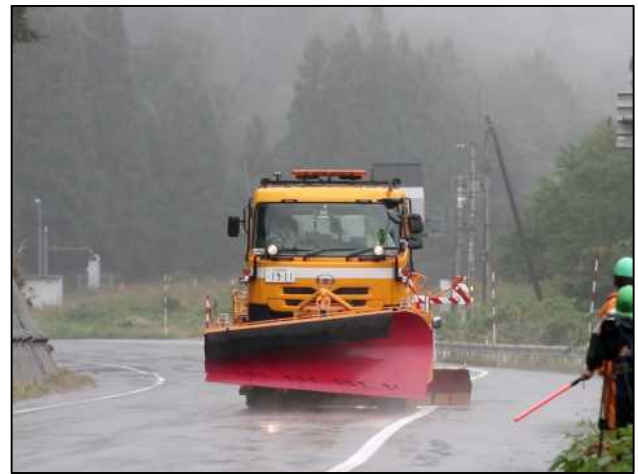
写真-6 降雪期前の現道試験実施状況（湯沢工区）
