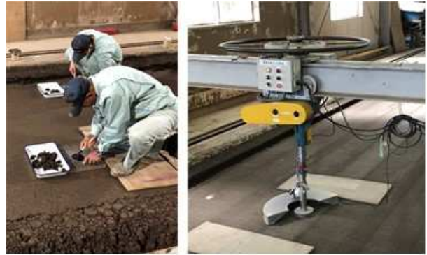
写真-2 測定状況 (左: 砂置換法, 右: CBR)
