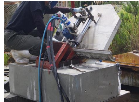
写真-1 ウォールソーによる頭部切断の様子
