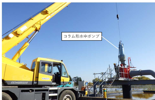
写真-2 コラム形水中ポンプ設置状況
