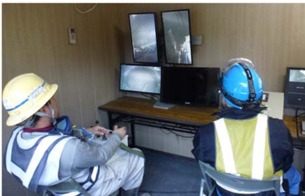
写真-1 遠隔吹付風景
