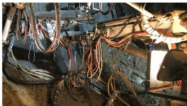
写真-3 配管配線状況
