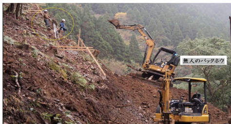
遠隔+丁張で掘削 危険区域に作業員
