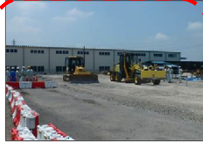
ICT建機施工体験(一社)日本建設機械施工協会
