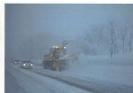
【拡幅除雪】290kw 級
