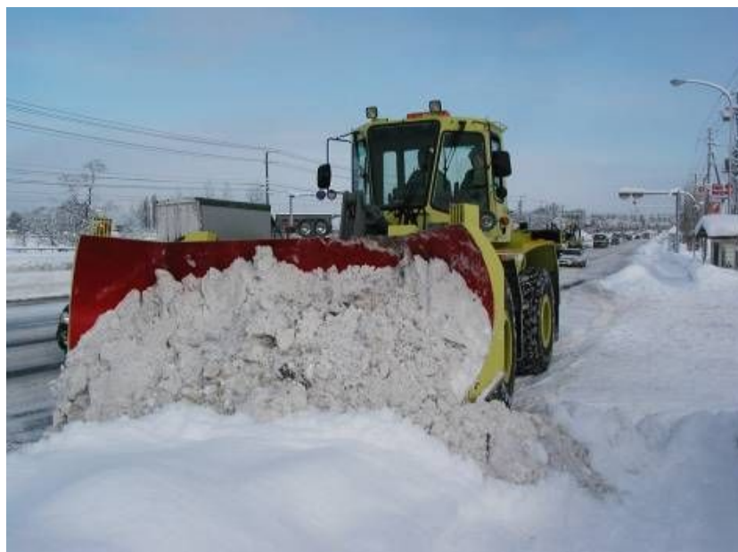
写真 Uブレードによる道路除雪作業中
