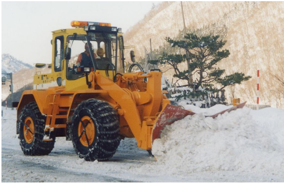
写真 スライドマルチプラウによる新雪除雪作業
