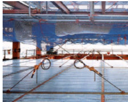
写真 2.3.21 鉄骨建方時の歪み直し
