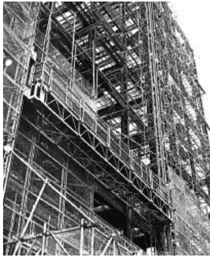
写真 2.4.6 ロープ式ロングスパン建設用リフト
