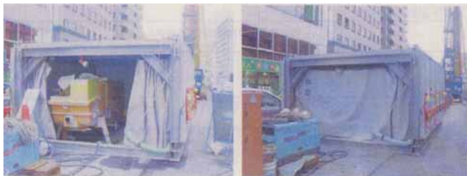
写真 6.3-2 防音壁（テント）の例
