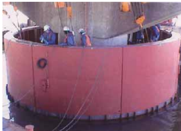
写真 6.5-4 鋼殻によるドライアップ状況
