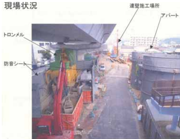
写真 6.4-1 振動篩を遠心力脱水機（トロンメル）に変更した例
