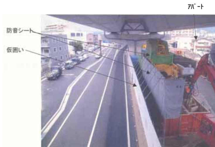
写真 6.3-1 仮囲いや防音シートによる対策状況
