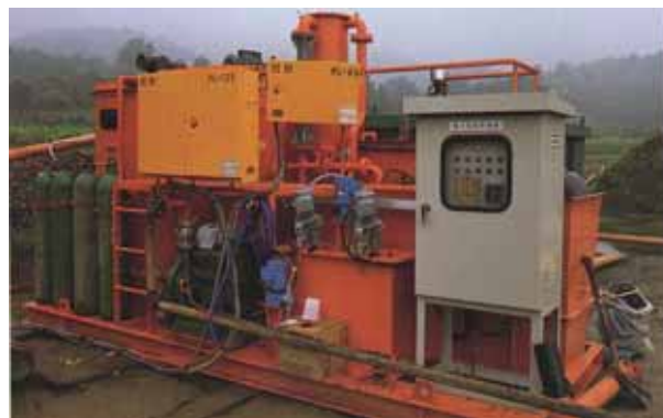
写真 6.5-3 濁水処理プラント
