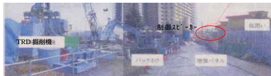
写真 6.2-2 逆位相音による騒音制御設備設置状況
